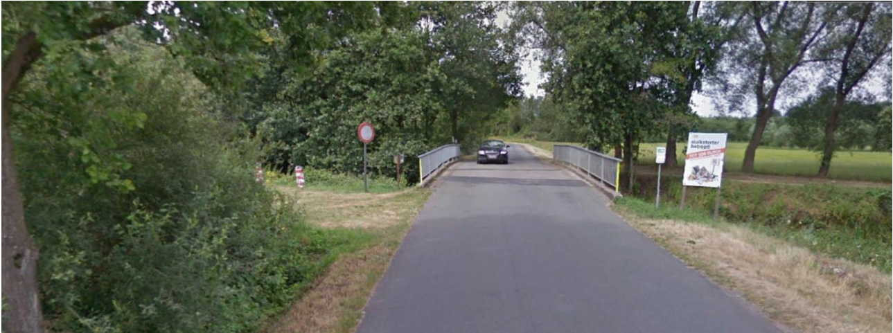
Figuur 4-6: Wildersedijk t.h.v. brug over de Nete
